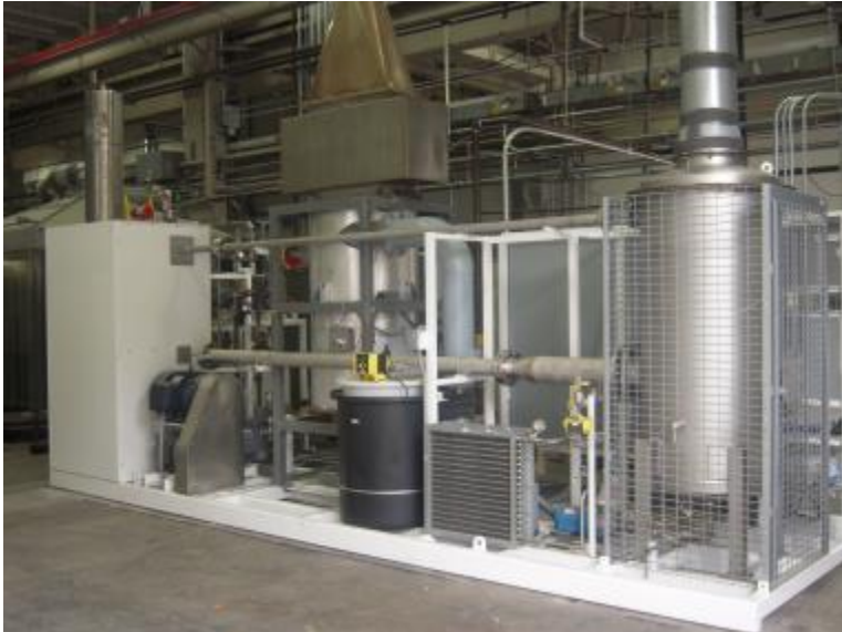
3 GPM iSCWO skid
