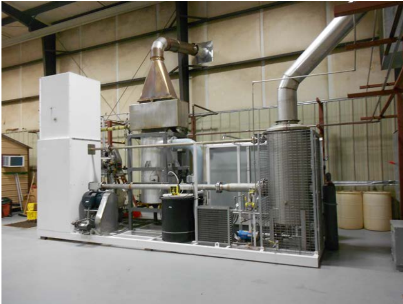
3 GPM iSCWO Skid
